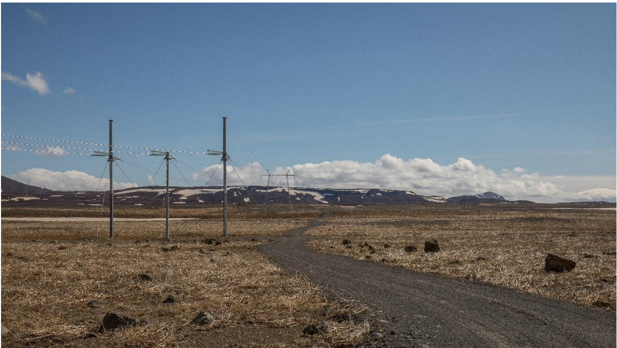
Mynd 6.3 Dæmi um hornmastur með jarðvír, stagaðar súlur úr stálrörum.
