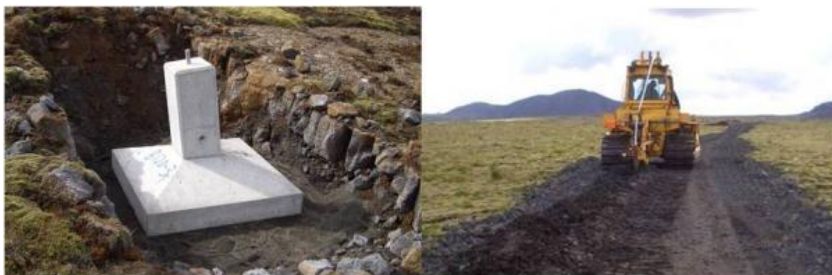
Mynd 6.4 Til vinstri má sjá forsteypta undirstöðu masturs og til hægri sést hvernig jarðskaut er plægt í kant á vegslóð.
